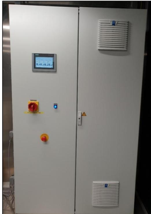
**Abbildung 16: Schaltschrank/Automatisierungsbox für die Regelungstechnik des Funktionsmusters**
