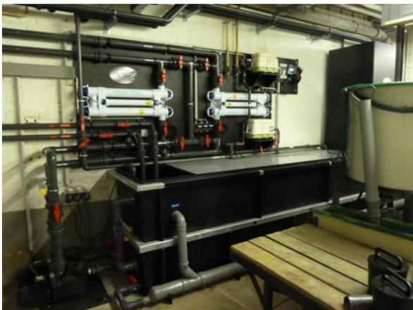
**Abbildung 43: Biofiltereinheit der Kreislaufanlage**
