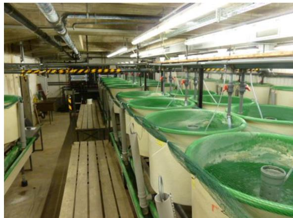
**Abbildung 44: Rundbecken der Kreislaufanlage**
